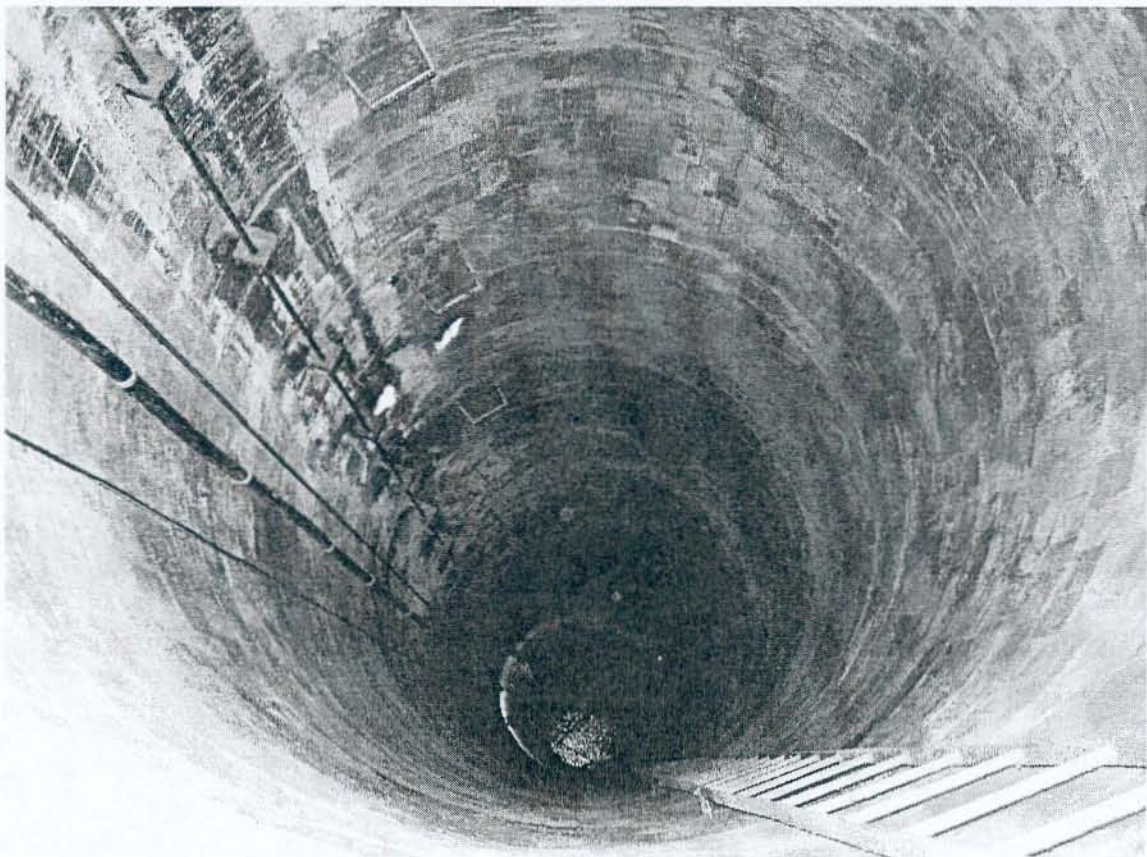
POZO PRINCIPAL DE LA MINA VELLA DE VILASSAR, CAUDAL = 8 L/s, NIVEL A UNOS 30 m, DIÁMETRO = 3 m
