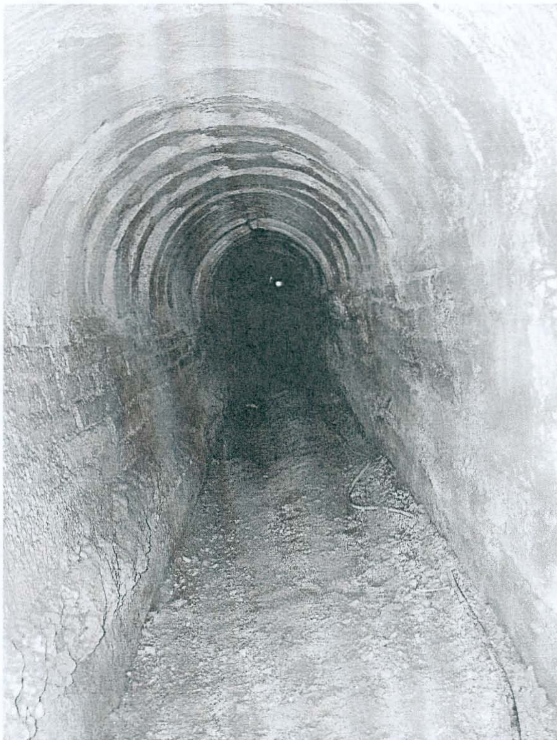
DETALLE DE UNA DE LAS MINAS DE CONDUCCIÓN DE LA MINA VELLA DE VILASSAR DE MAR, ACTUALMENTE SECA O NO FUNCIONAL, VERANO 2004
