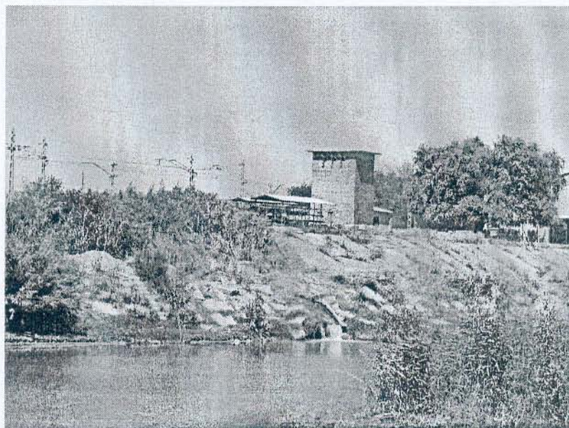
Captaciones de agua subterránea de Martorell (Baix Llobregat, Barcelona), junto al río Llobregat, con problemas de hierro y manganeso (verano 2004)
