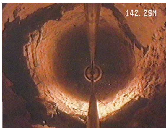
Degradación del entubado
