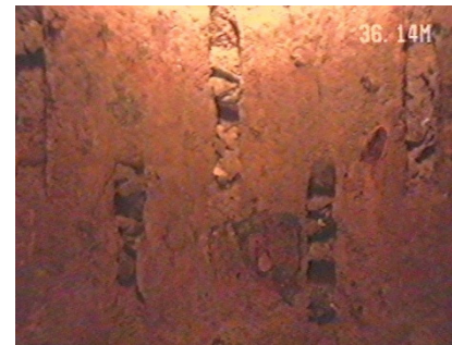
Inspección con TV
